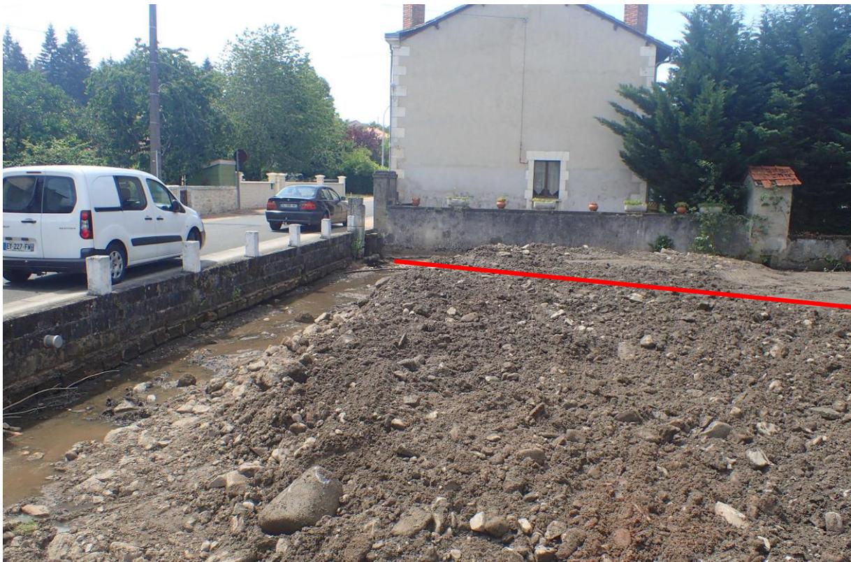
***Comblement du canal avec les résidus issu du déblai. La buse sera posée par la suite (tracée en rouge)***
