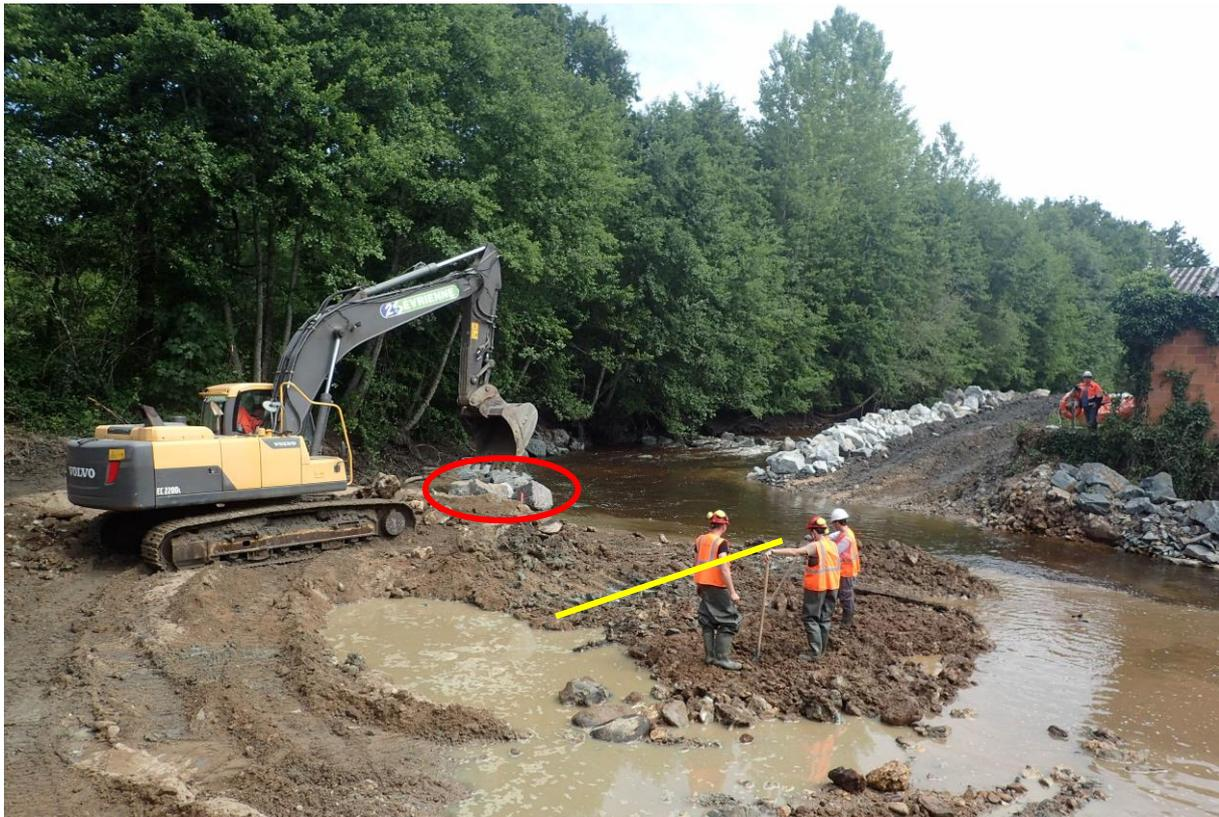
*Mise en place de l'enrochement en rive gauche (en rouge). L'ancien seuil a été révélé suite à la déconstruction de la digue en béton et l'abaissement du niveau d'eau (en jaune).*
