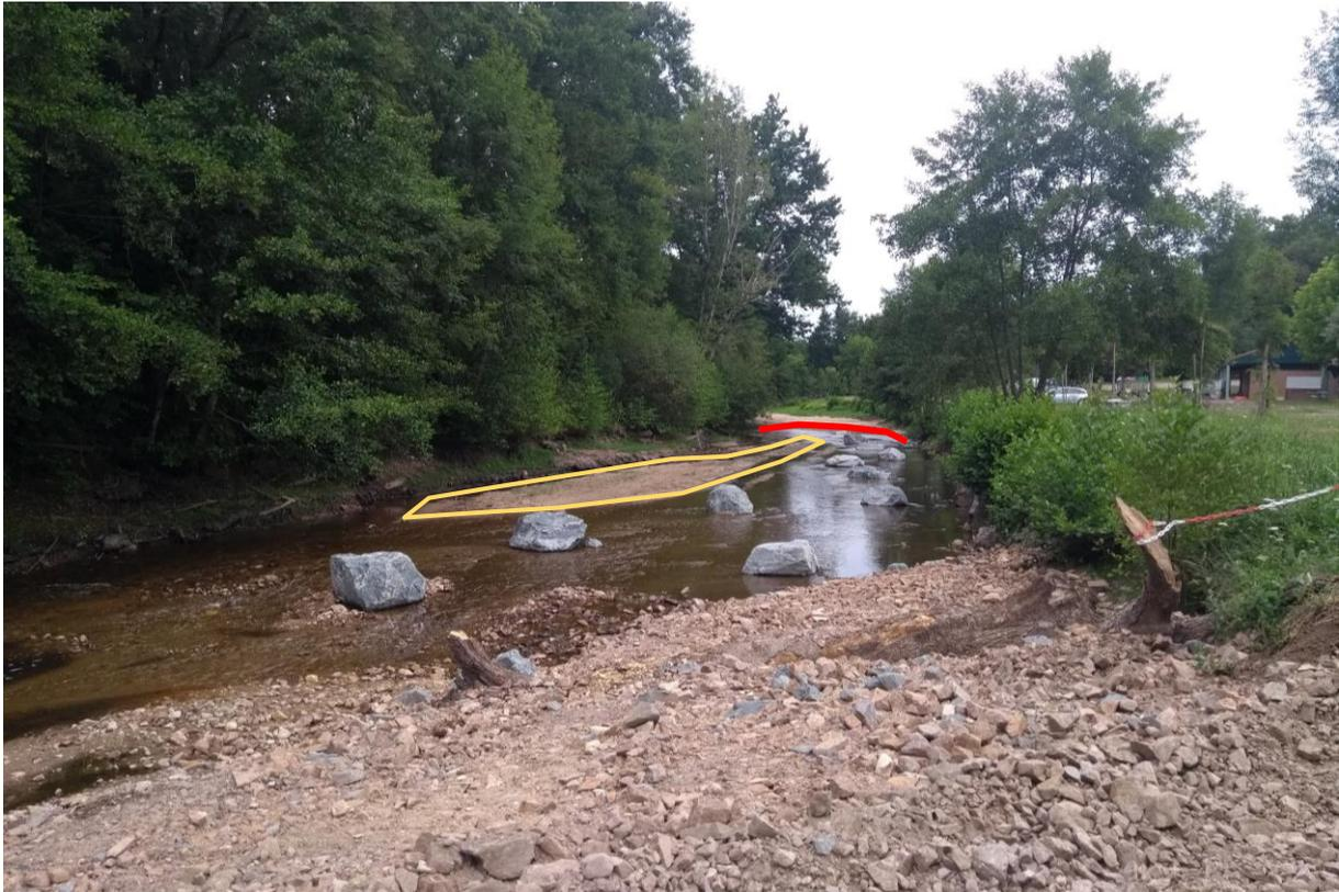
***Vue du lit après les travaux : On observe les blocs en amont de l'ancien seuil. L'abaissement du niveau a révélé un dépôt naturel de sable formant un îlot (en jaune) qui se modifiera en fil des crues. En rouge, la berge rive gauche le long du camping a été aménagée avec le sable issu de l'îlot (ci-dessous).***
