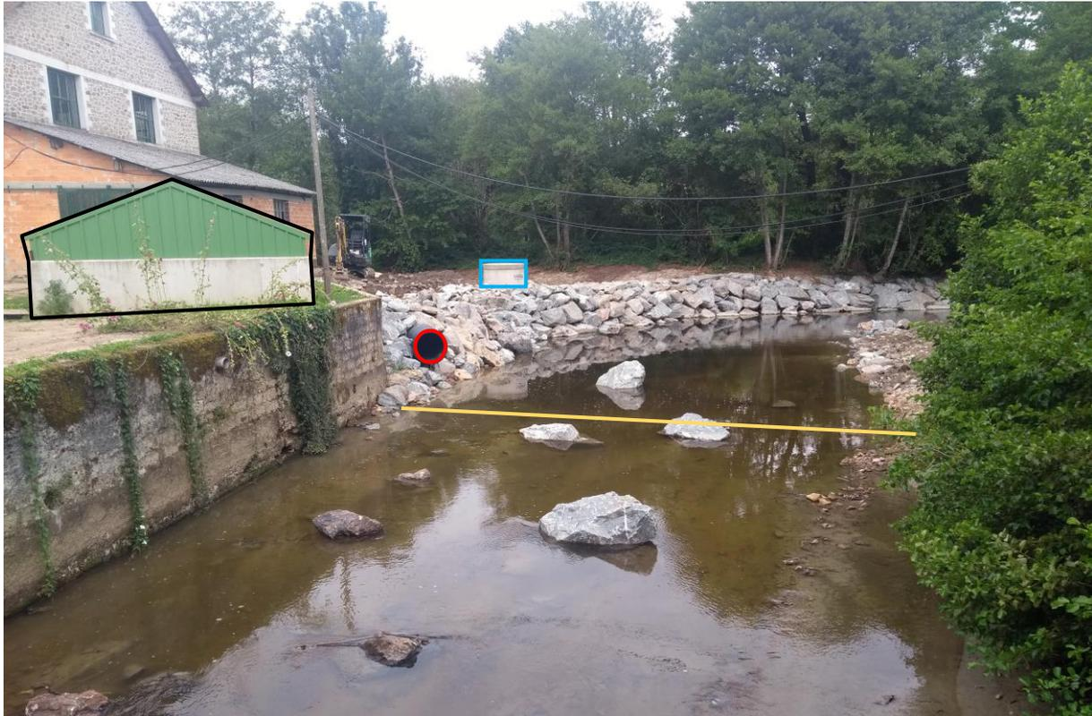
*Vue en aval de l'ancien seuil (en jaune) à la fin des travaux. On observe la buse de canalisation des eaux pluviales (en rouge), le puit (en bleu) et la cuve de stockage (en noir).
