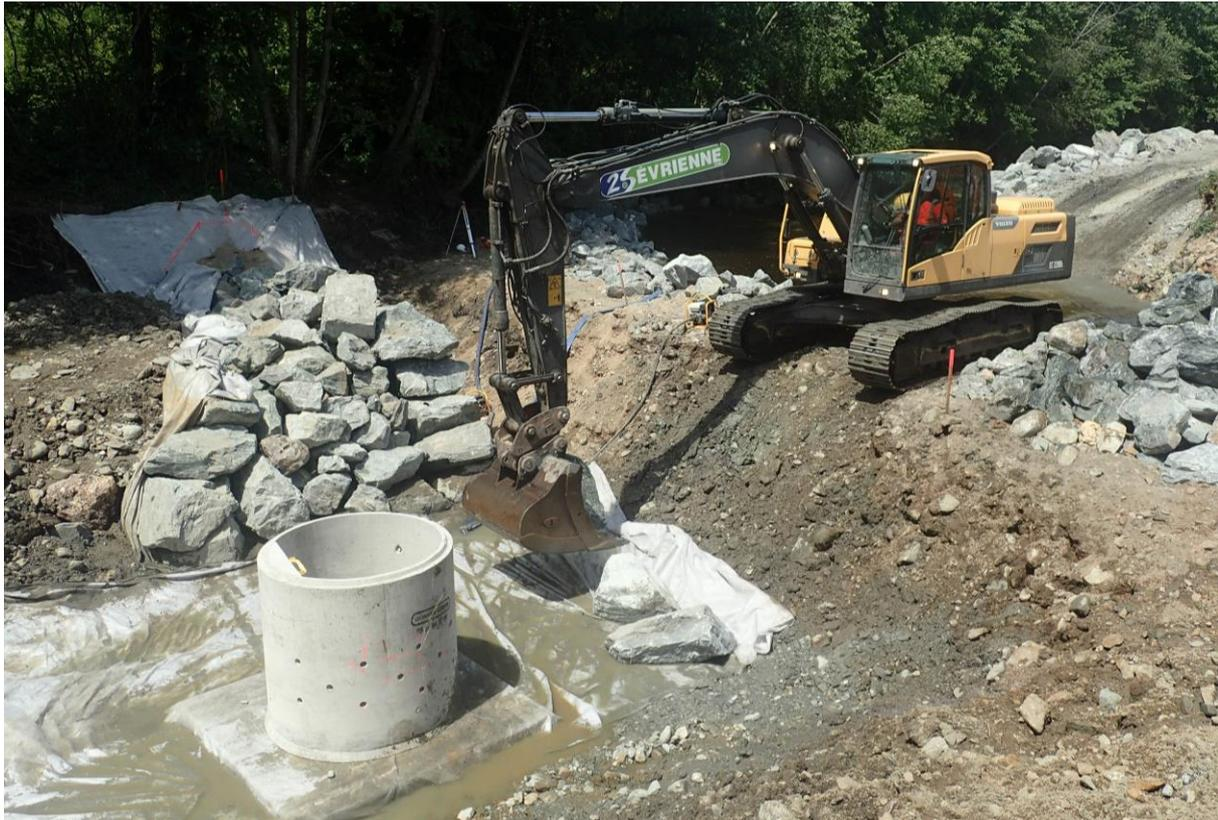
***Aménagement du puit de pompe qui alimentera la cuve. En parallèle, pose de l'enrochement progressive.***
