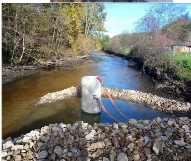
Figure 7 : Photos des travaux 2017 - en haut : reprise de la canalisation et de l'ancien bief sur le site 15 - En bas : pompage provisoire et curage des sédiments sur le site 14
