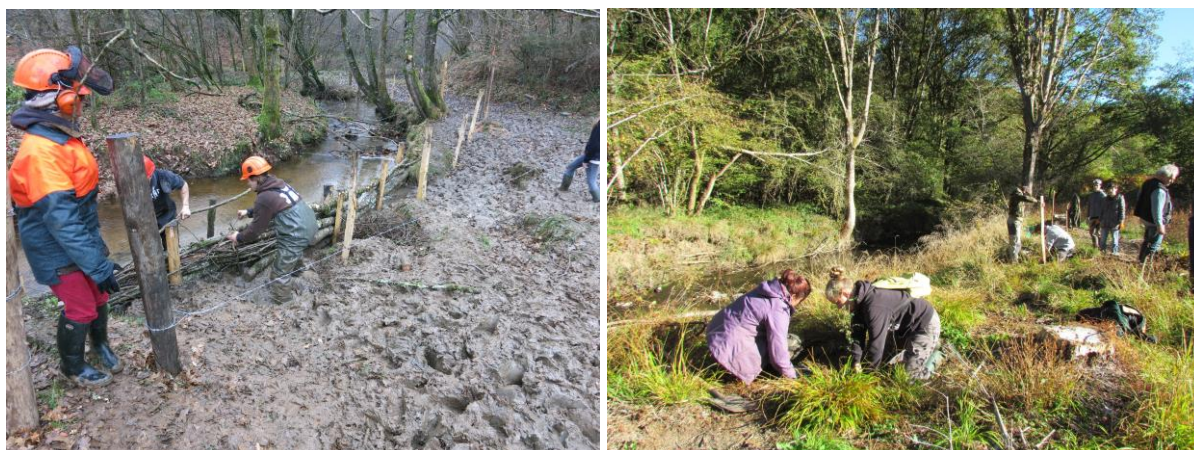
Figure 19 : chantiers de mise en défens des berges et plantation de ripisylve
