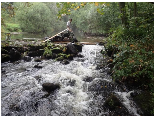
Figure 8 : Photos des travaux 2017 sur le site 12 : élargissement de la brèche existante et enlèvement d'un embâcle menaçant de l'obstruer
