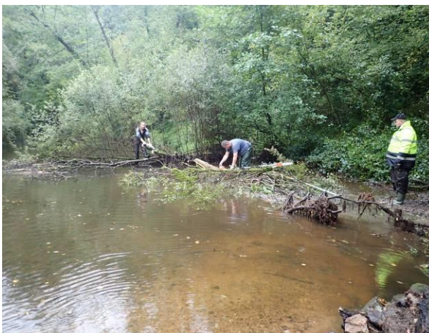
Figure 8 : Photos des travaux 2017 sur le site 12 : élargissement de la brèche existante et enlèvement d'un embâcle menaçant de l'obstruer
