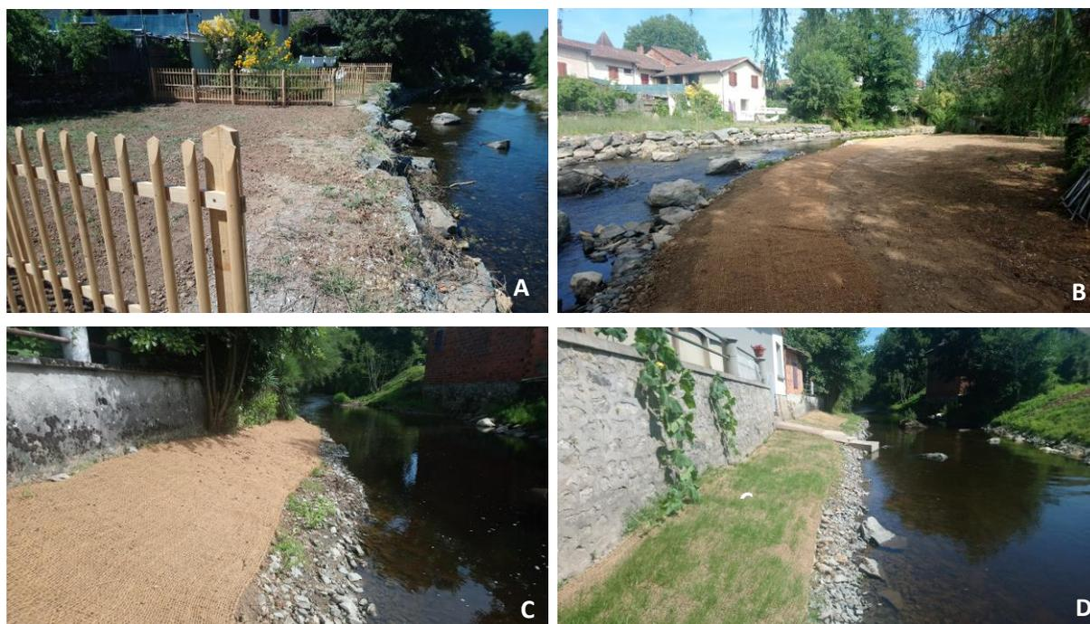
Figure 5 : Reprise des travaux sur le site n°15. (A) clôtures de séparation, (B) apport de terre végétale en rive gauche, (C) apport de terre végétale en rive droite, (D) repousse de la végétation.
