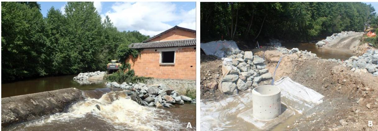
**Figure 6: (A) Brèche dans le seuil. (B) Installation du puit**
