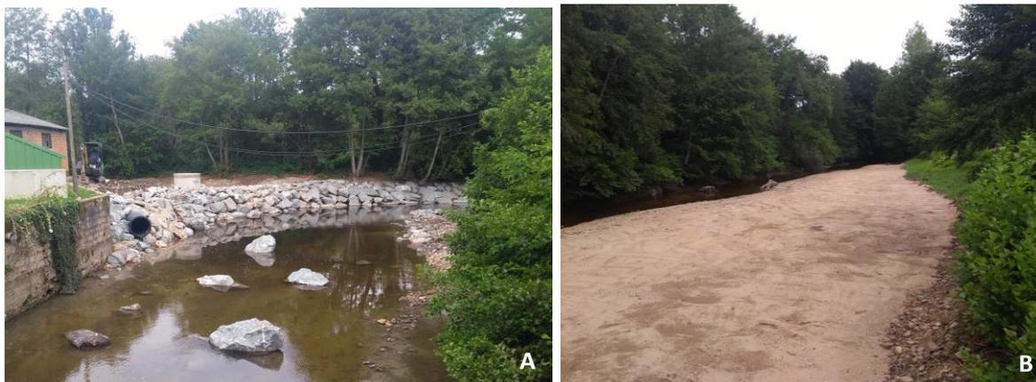
Figure 7: (A) Enrochement de la berge en rive droite dans le virage. (B) Nettoyage des berges au niveau du camping et aménagement d'une banquette de sable.
